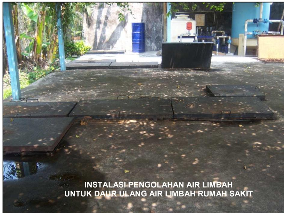
Pengolahan limbah untuk daur ulang pada Rumah Sakit Panti Rapih, Yogyakarta menggunakan metode/sistem bio reaktor. Dimaksudkan untuk pemenuhan penyiraman tanaman tanpa menambah alokasi air dari sumber air.
